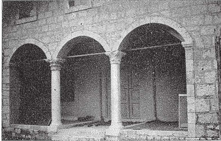
Resim 30. Taşucu camii'nin giriş mahalli.
