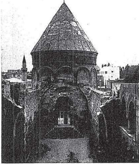
Res. 25. Eyvanın ve türbenin damdan görünüşü.
