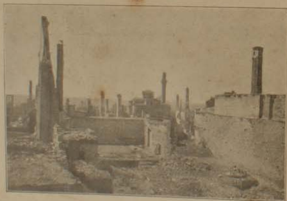
۱۰ تموز حریق : مسیح پاشای عتیق محله سی آلاجه مسجد جاده سی Une vue de l'incendie du 10 Juillet
