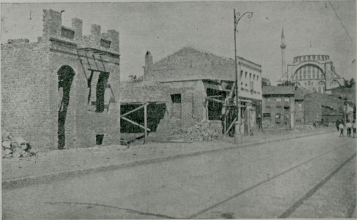
17 — Tramvay işlemeğe başladıktan sonra cadde üzerinde inşaat faaliyeti (yalnız Edirnekapı ile karagümruk arasında 8 bina yapılmaktadır)
