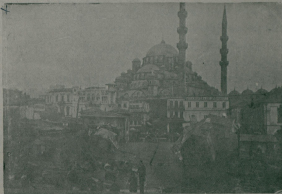
یکی کوپرمزک اغلا نه جق حال — قصادن سکره Après l'accident du pont
