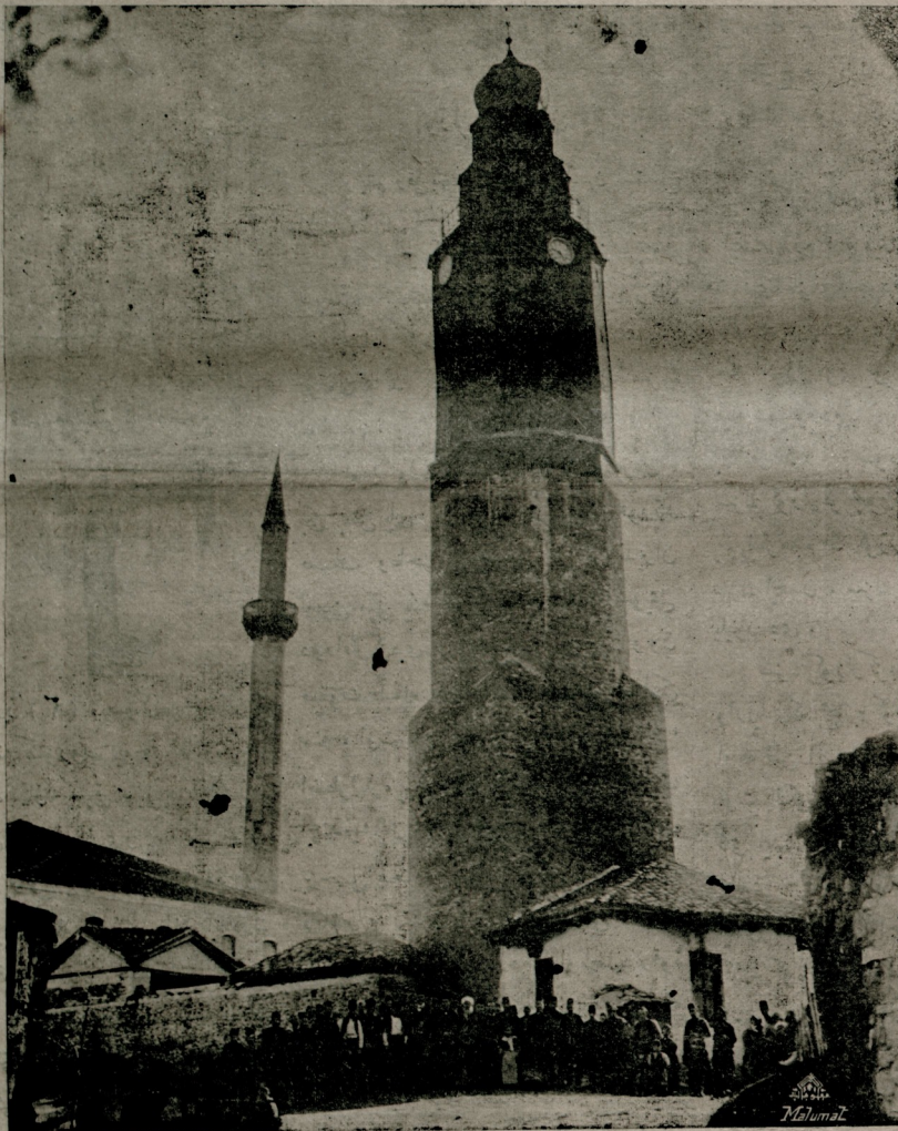
اسکوبده ۳۹ مترو ارتفاعنده انشا ایدیلن ساعت قله سی
