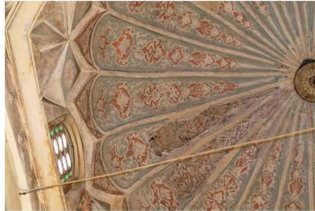
Görsel 12 Giriş solundaki eyvanın dilimli kubbesi.
