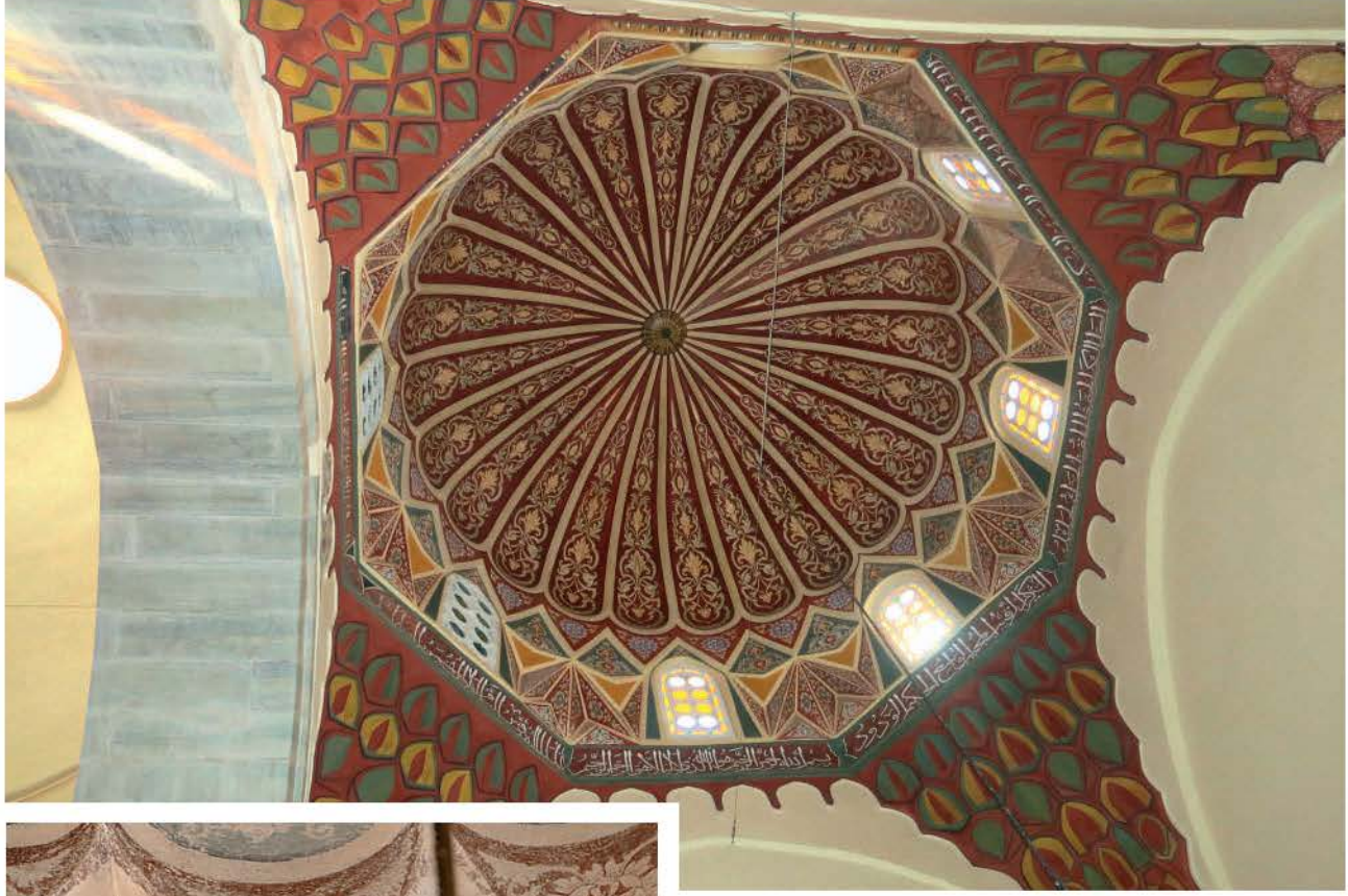
Görsel 13 Eyvan kubbesi 2010 onarım sonrası.
