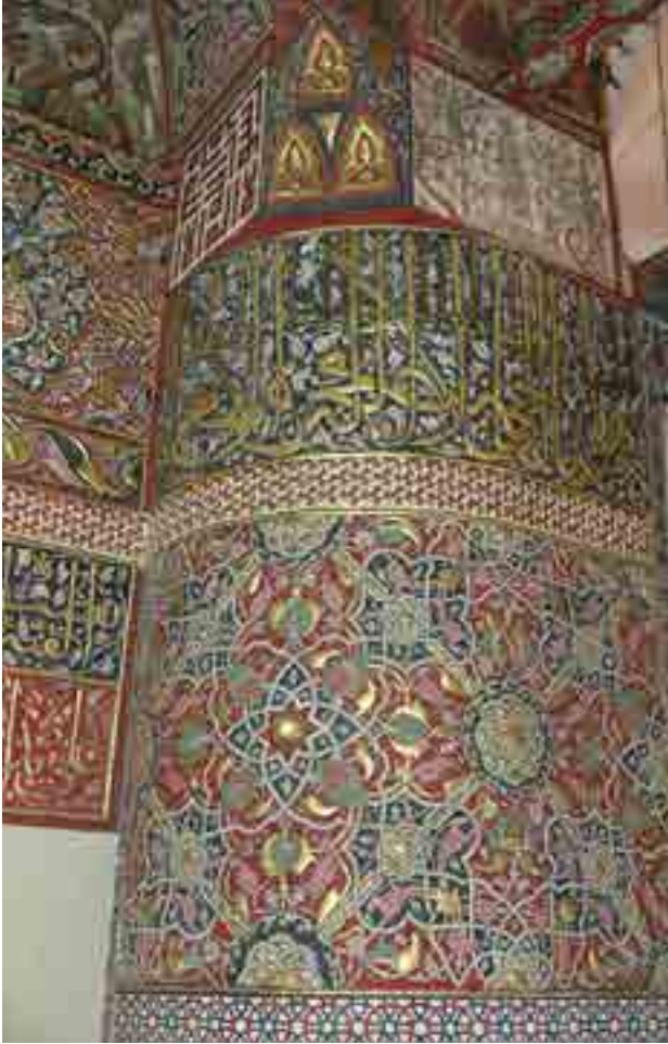
Fotoğraf 20. Güney cephesi filpayenin onarım sonrası
