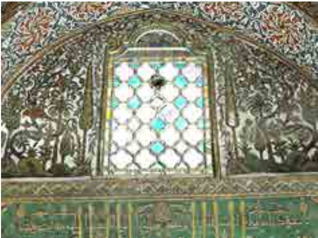
Fotoğraf 16. Güney cephesi hayat ağacı (Onarım öncesi)
