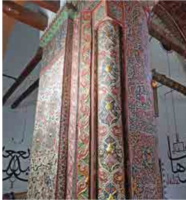
Fotoğraf 22. Kuzey cephesi filpayesinin yan yüzeyi
