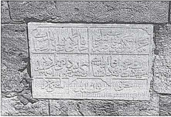
Şekil 13 Yeni Camii Minare Kâidesindeki Minare Onarım Kitâbesi
