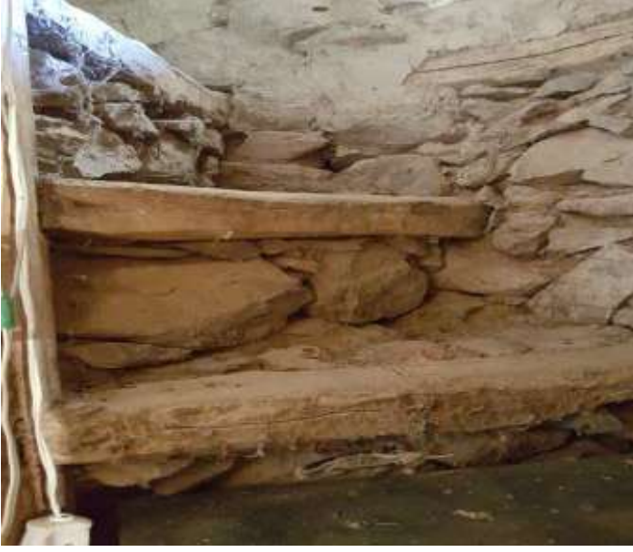
Resim 9 Minareye Çıkan Merdivenler
