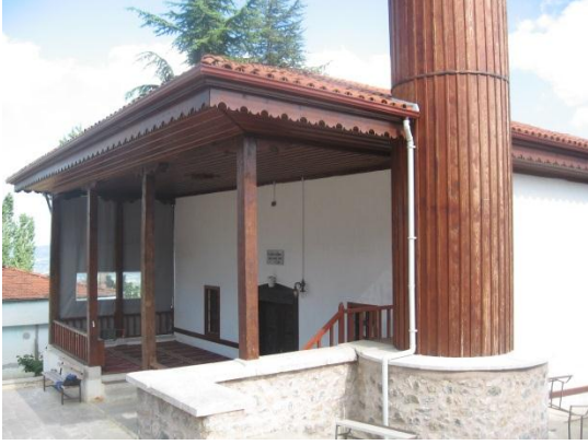
Fot. 25 Aşağı Baraklı Camii kuzey cepheden görünüm
