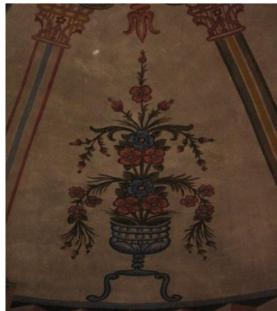
Fot. 41 Aşağı Baraklı Camii tavan bezemesi detayı
