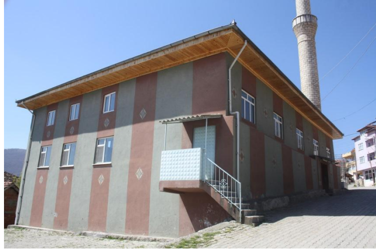
Fot. 3 Yukarı Baraklı Camii kuzey ve doğu cepheden görünüm
