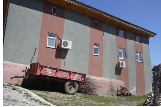
Fot. 5 Yukarı Baraklı Camii güney cepheden görünüm
