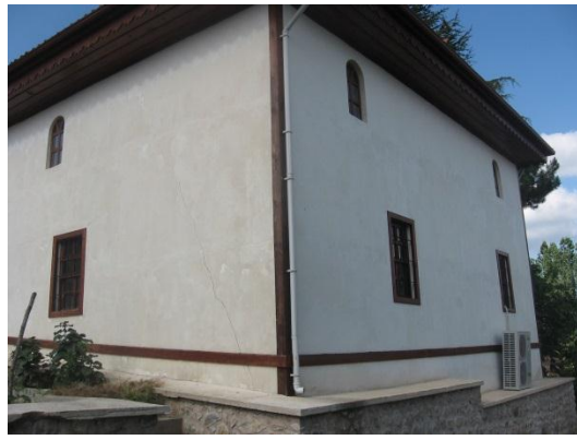
Fot. 28 Aşağı Baraklı Camii güney cepheden görünüm
