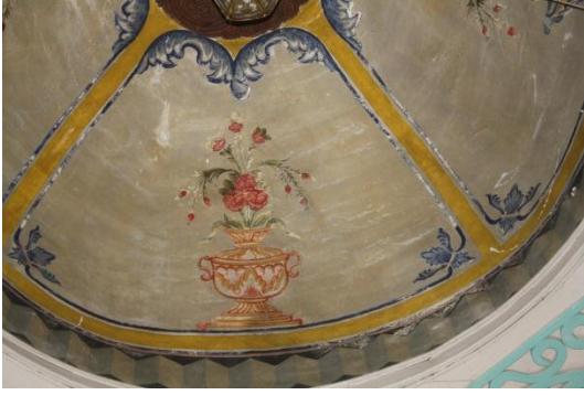
Fot. 20 Yukarı Baraklı Camii tavan bezemesinden detay
