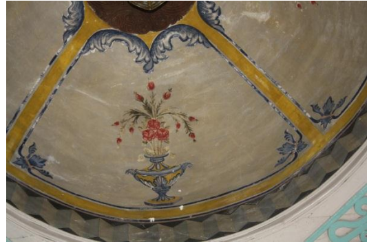
Fot. 21 Yukarı Baraklı Camii tavan bezemesinden detay
