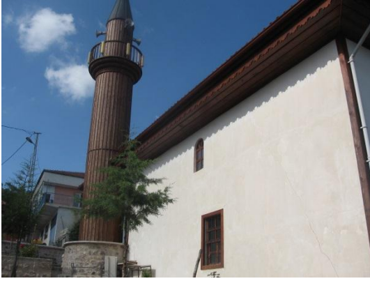
Fot. 27 Aşağı Baraklı Camii batı cepheden görünüm
