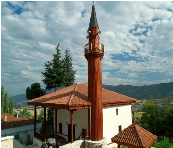
Fot. 23 Aşağı Baraklı Camii genel görünüm
