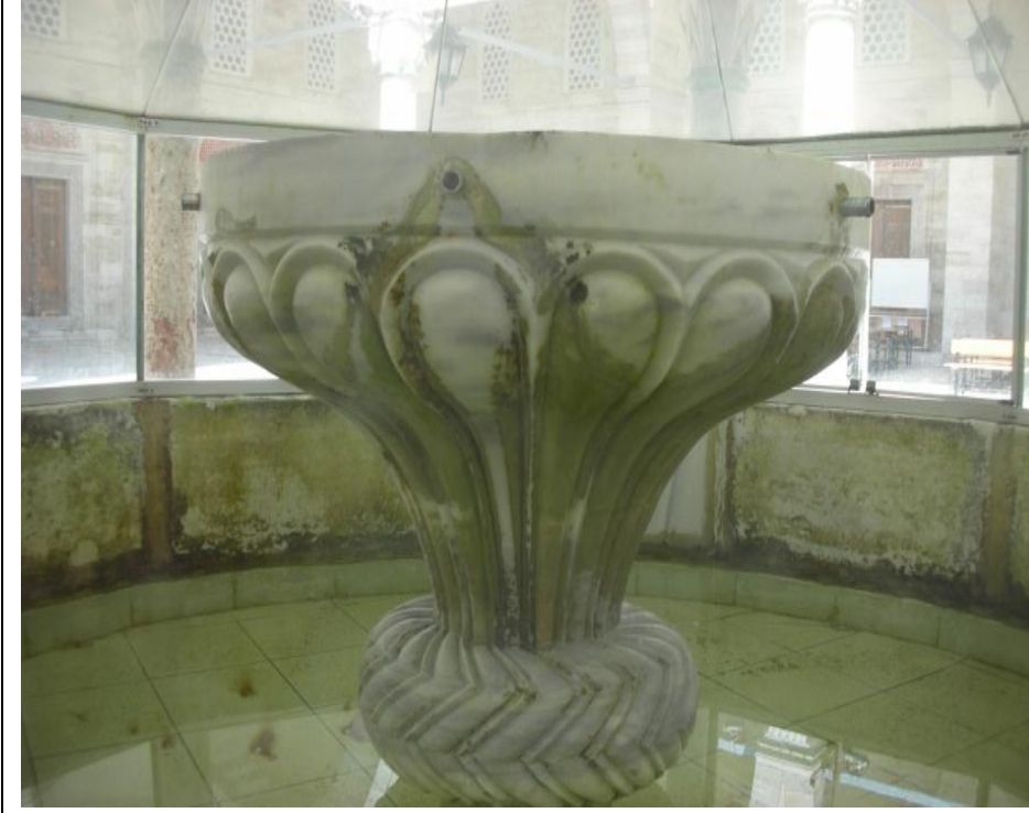
Fot.20, Şehzade Cami Şadırvanı Kurnası
