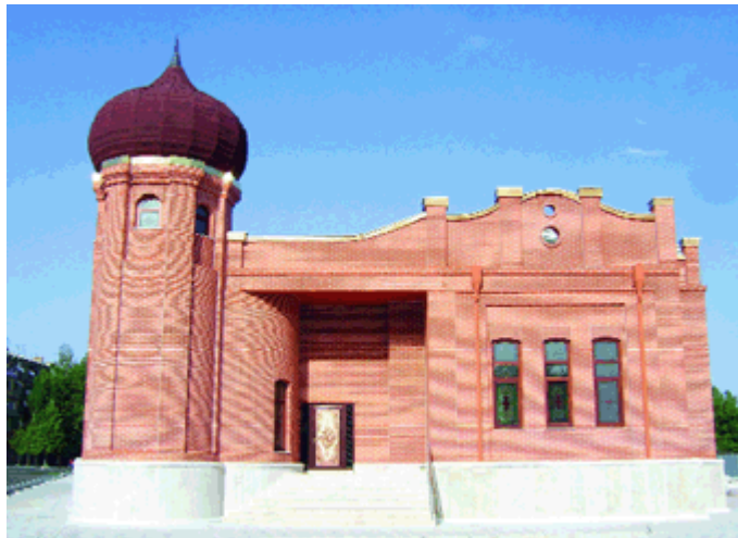
Zaviye-Medrese Binası (XVII-XVIII. asırlar)
