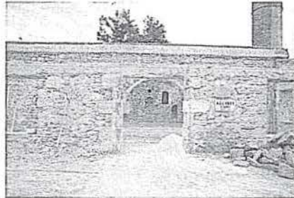
Fotoğraf 3. Ağca Bey Camii Kuzey Cephesi Restorasyon Esnasında Görünümü (VGM Arşivi)
