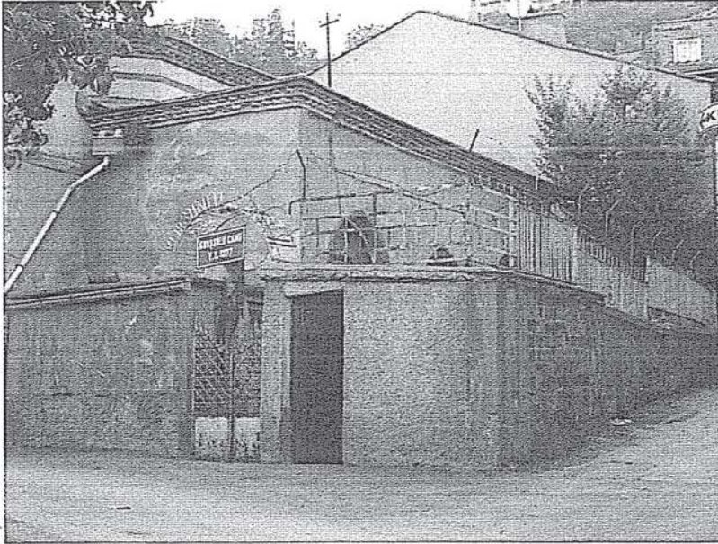
Resim.2: Yapının kuzeydoğu yönünden görünümü (2013) (Fotoğraf: E. AKOVA).
