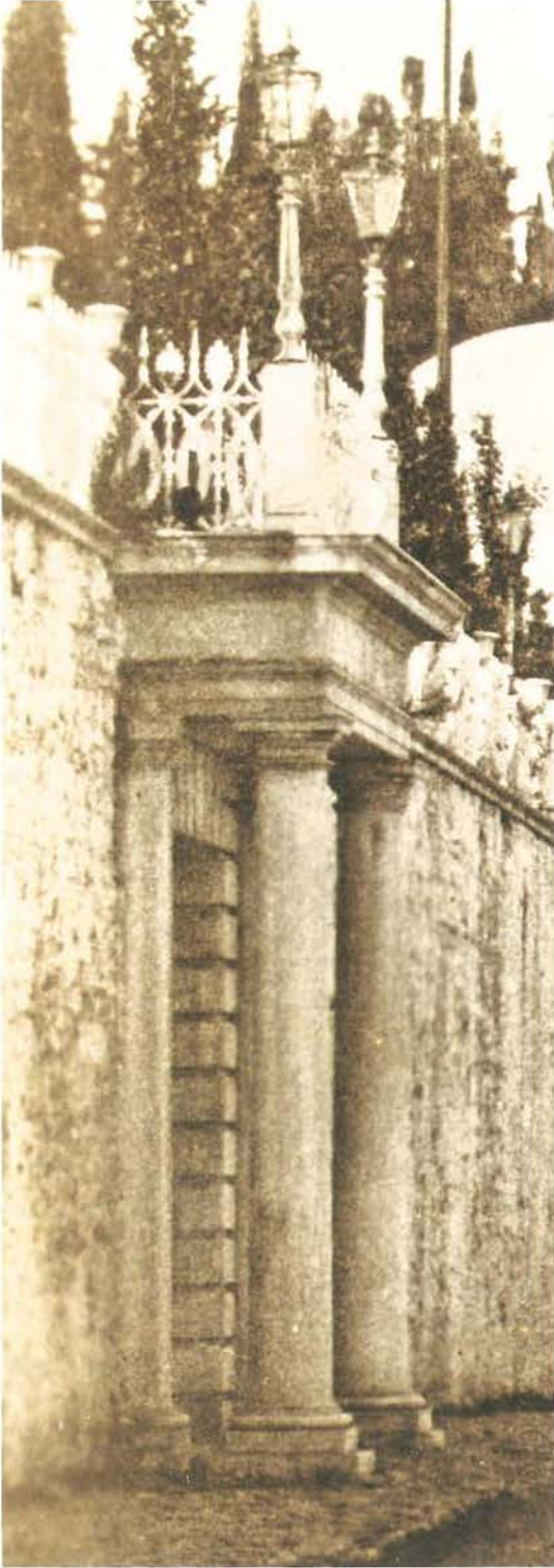
Figür 20- Yıldız Bahçesi'nin Çırağan Caddesi'ne açılan kapılarından biri. Bu kapı bugün de duruyor, ancak zemini neredeyse bir metre kadar yola gömülmüş haldedir.
