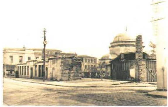
Figür 4- 1943-1944 seneleri arasında gerçekleşen istimlâklerde Beşiktaş Çırağan yolu üzerindeki pek çok yapı yıkıldı. 1943'e ait fotoğrafta Barbaros Hayreddin Paşa Türbesi'nin çevresindeki yapılar yıkılmakta olduğu görülüyor (Encümen Arşivi).
