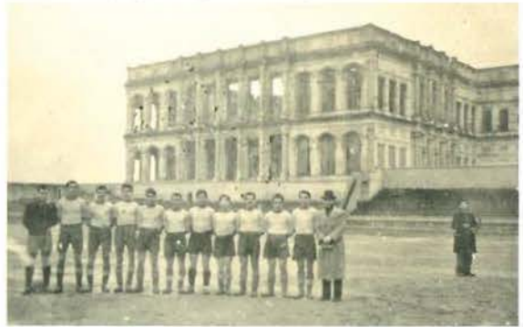
Figür 13- Çırağan Sarayı'nın bitişiğindeki selamlık bahçesi Beşiktaş'lı Şeref Bey'in gayretleriyle BJK'ne tahsis edilmişti. Uzun yıllar Beşiktaş antrenmanlarının yanı sıra lig müsabakalarını da bu bahçede inşa edilmiş top sahasında gerçekleştirmişti (Burak Çetintaş Arşivi).
