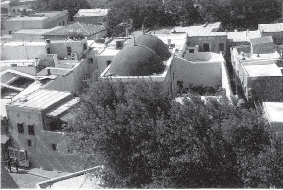
1 Fethi Paşa Kütüphanesi, Genel Görünüşü
