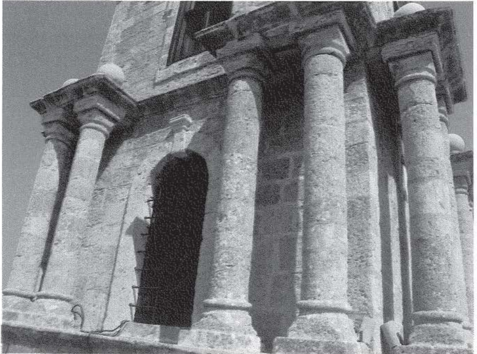
16 Fethi Paşa Saat Kulesi, Cephelerdeki Sütun Detayları
