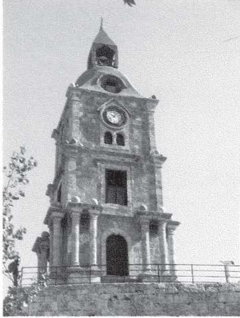
13 Fethi Paşa Saat Kulesi, Arka Cephe Görünüşü
