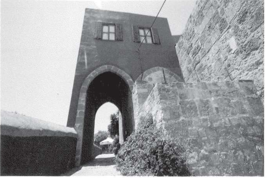
19 Fethi Paşa Rüştüyesi, Genel Görünüü
