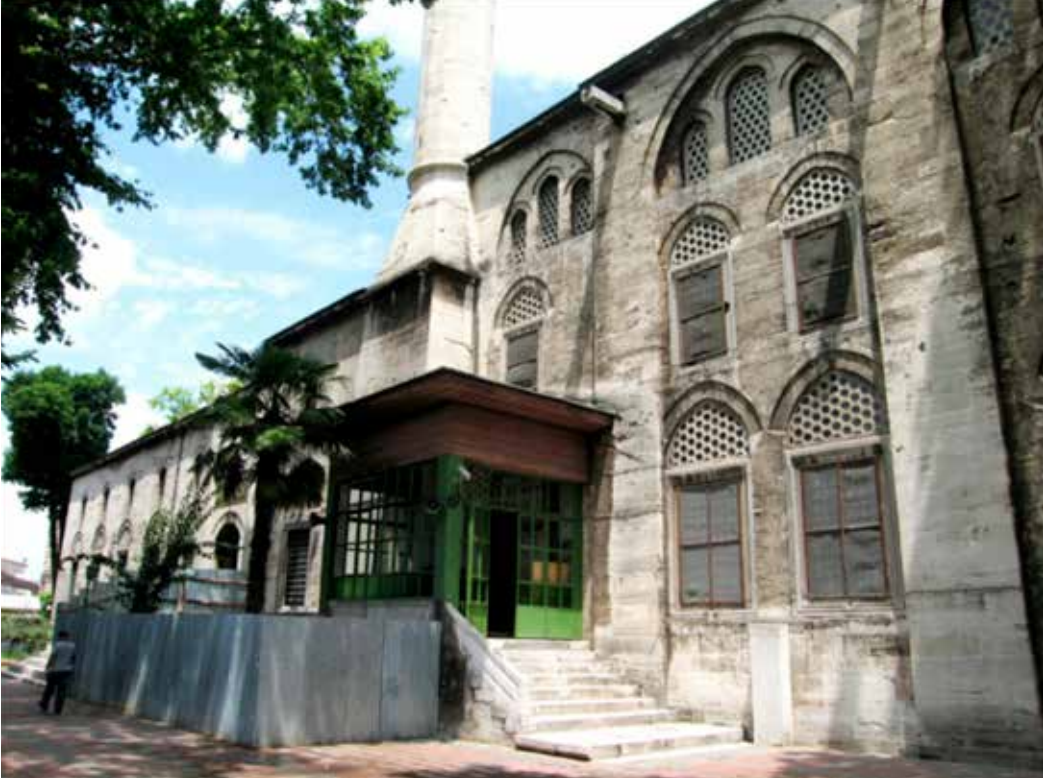
Resim 20: Caminin batı cephesi
