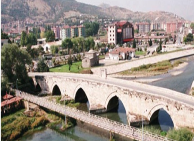
Resim 1. Hıdırlık Köprüsü ve Şeyh Meknun (Açıkbaş) Türbe ve Zaviyesi
