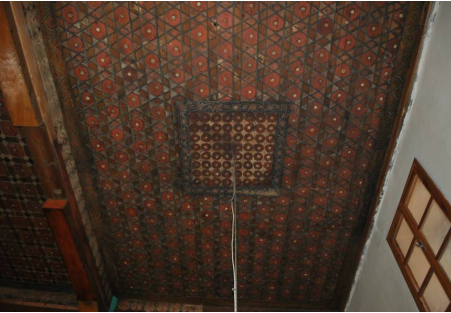
Fotoğraf 9: Güneydoğudaki tavan bölümü
