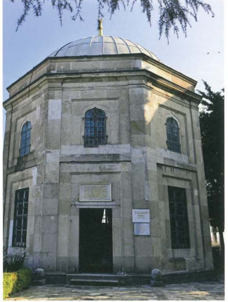
11- Sultan Abdülmecit Türbesi
