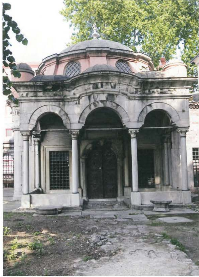
17- Şehsuvar Valide Sultan Türbesi
