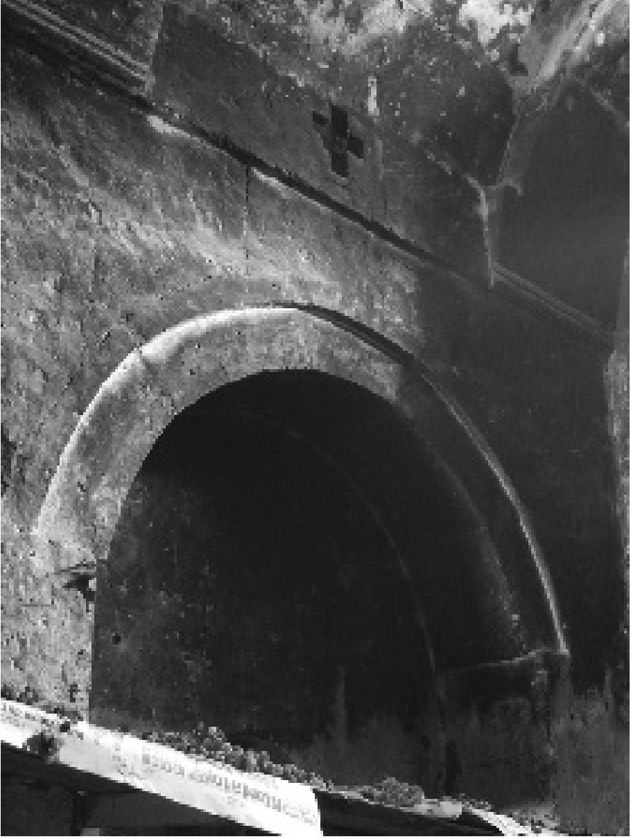
Fotoğraf 14: Ev Şapeli Kuzeydoğu tarafta niş ve haç.
