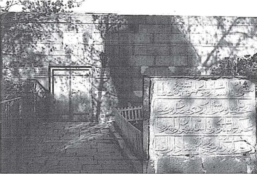
Foto 14: Şeyhler Medresesi Giriş Kapısı ve Üzerindeki Kitabe
