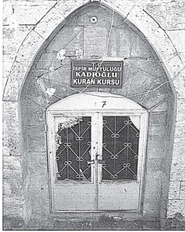
Foto 4: Medresenin Giriş Kapısı
