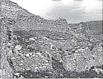
Resim 24: İki Katlı Yatakbane (Keşiş Odaları) Kısımının Güneybatıdan Genel Görünüşü
