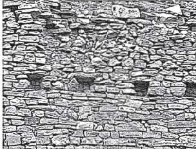
Resim 25: İki Katlı Yatakbane (Keşiş Odaları) Kısımının Güneybatıdan Genel Görünüşü
