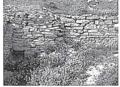
Resim 23: Mutfak Bölümünün Kuzey Duvarı ve Bu Duvardaki Kapı
