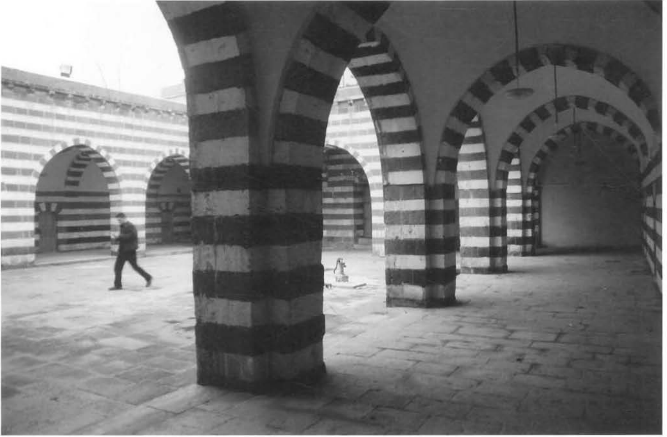
Foto: 10- Hüseyin Paşa Medresesi Revak Sistemi.
