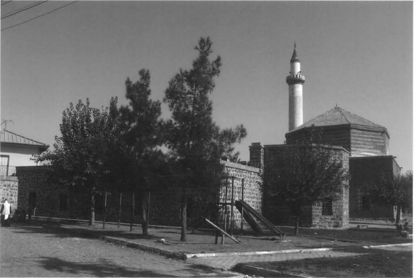
Foto: 20- Ali Paşa Medresesi, Güneybatı Cephesi ve Pencere Sistemi
