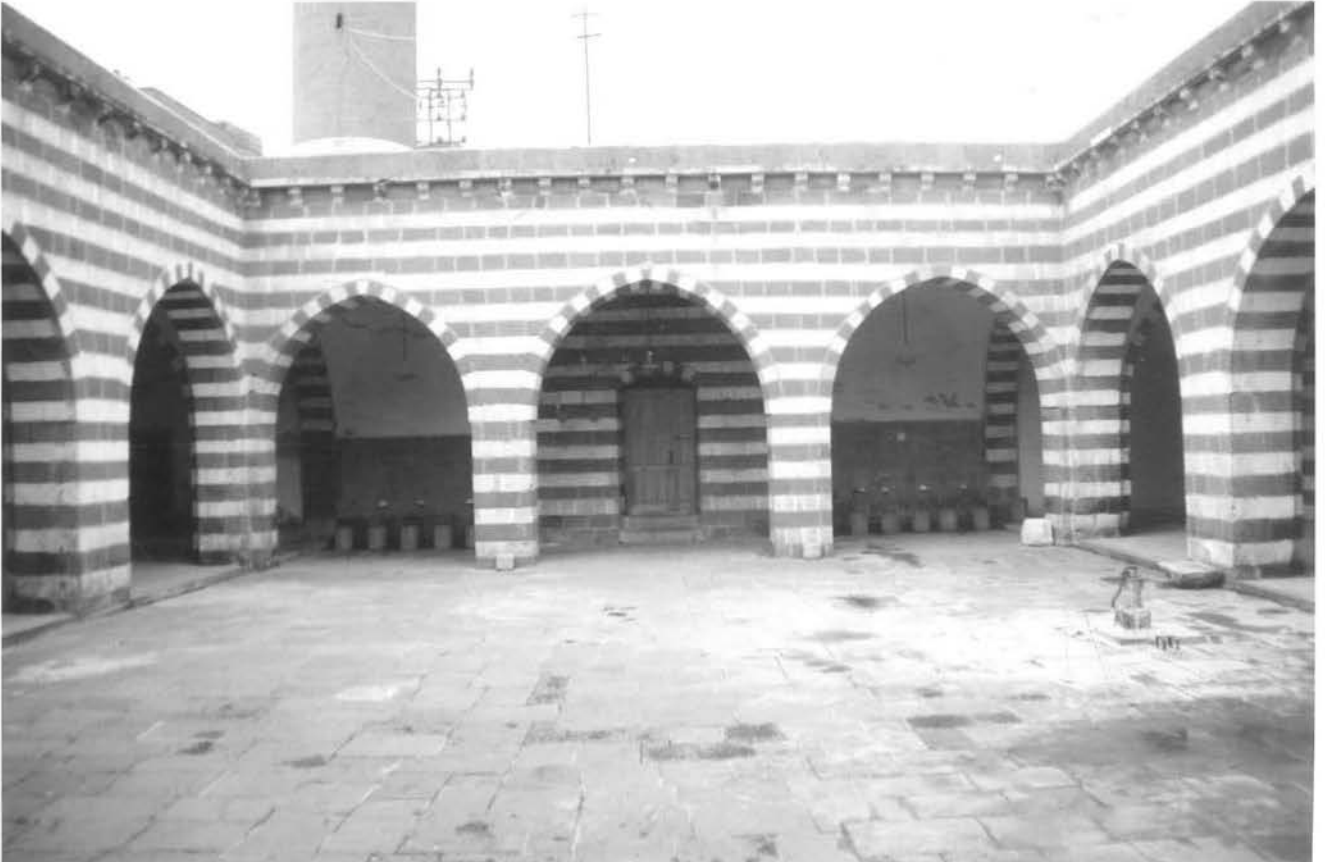
Foto: 2- Hüseyin Paşa Medresesi, Kuzey Yöndeki Girişi, Avlu ve Revakları. (İ. Yıldız'dan)
