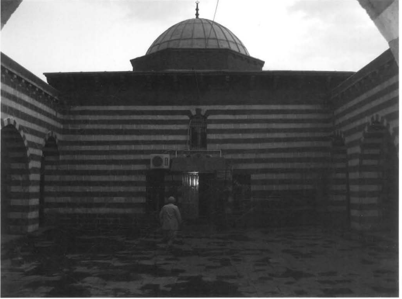
Foto: 1- Hüseyin Paşa Medresesi, Ana Dershane, Avlu ve Revakları
