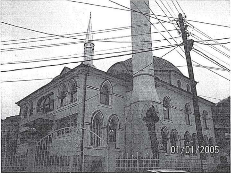
Altta: Kurila Camii'nin son restorasyondan sonraki durumu
