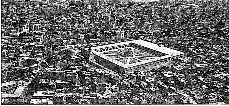
Foto. 1 Tolunoğlu Camii'den genel görünüm
