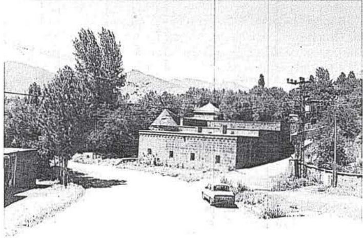
Resim 5 • Yusufiye Medresesi güney cephesi
