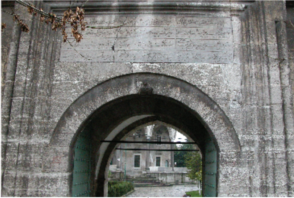
Üstte Veliyyüd-dîn Efendi'nin celî ta'lîk hatlarının bulunduğu Hekimoğlu Ali Paşa Külliyesi'nin Giriş Kapısı (1734)
