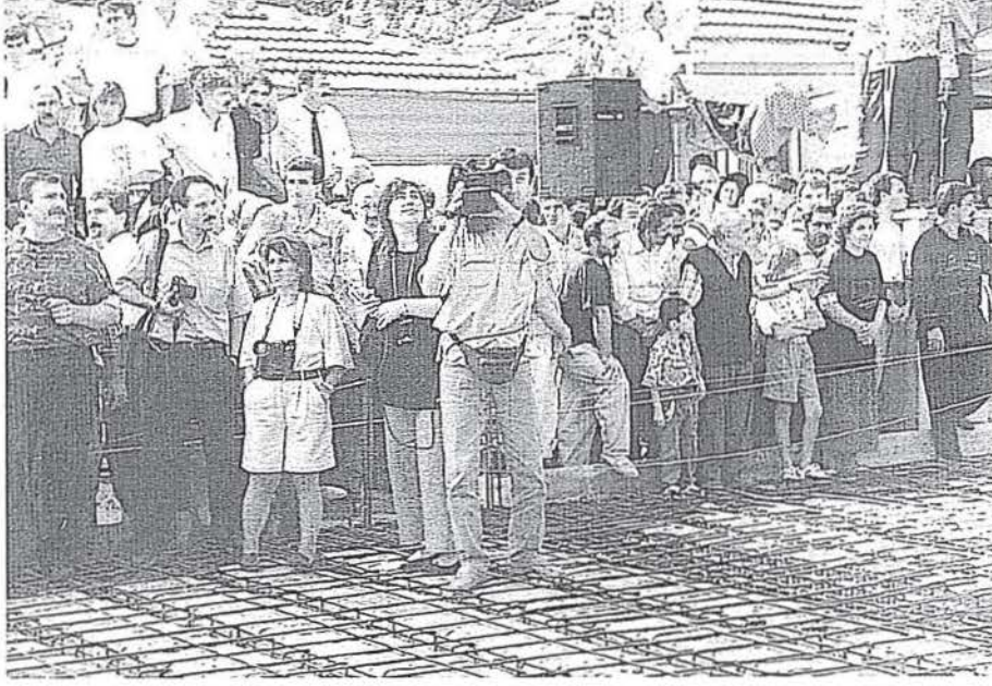
Dergah'ın Yıkımı Sırasında Yeni İnşaat
