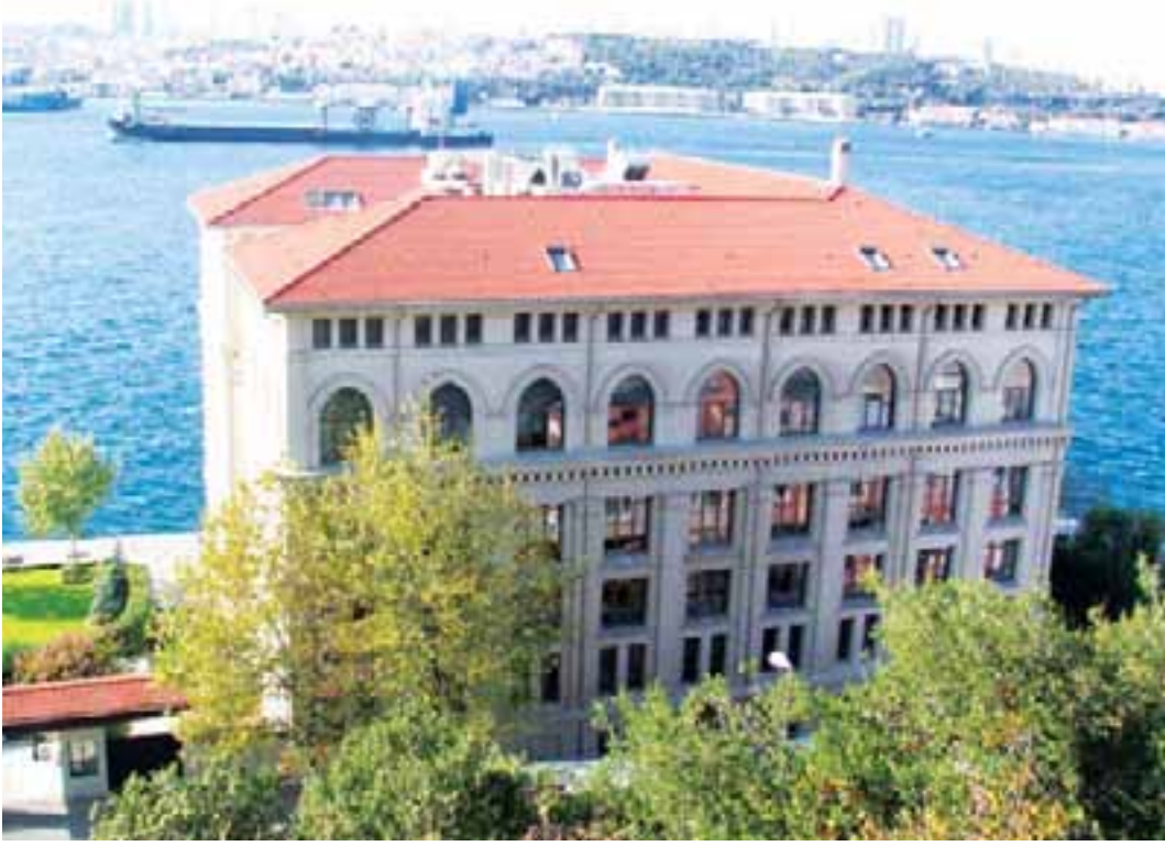
Nemlizade Tütün Deposu'nun genel görünüşü.
