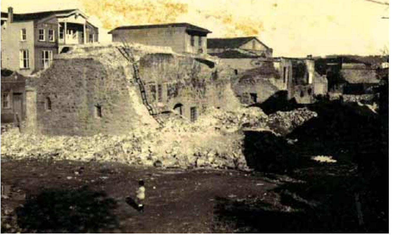
1931'de Kervansaray binası yıkılırken (Kültür ve Turizm Bakanlığı İstanbul Encümen Arşivi)
