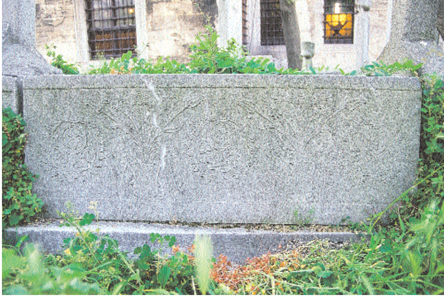
Fot. 7b: Nu. 1'in sağ pehlesi bezemeleri
