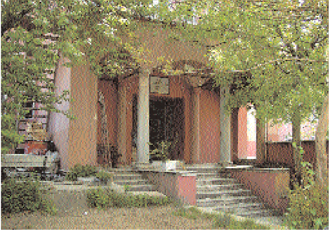
Surp Haç Okulu'nun tarihi binası - Giriş cephesi
