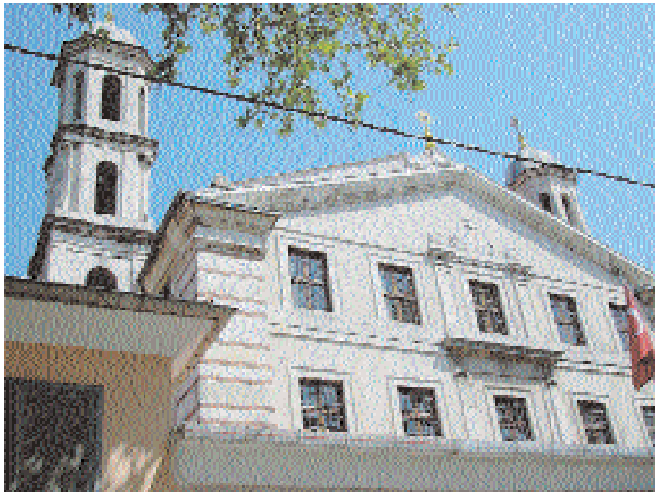
Surp Garabed Kilisesi - Batı Cephesi
