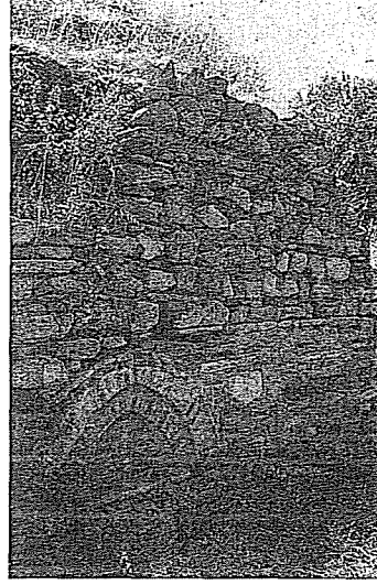
Resim 20. Selçuk, III No.lu Türbe. Batı duvarı ve giriş açıklığı.
