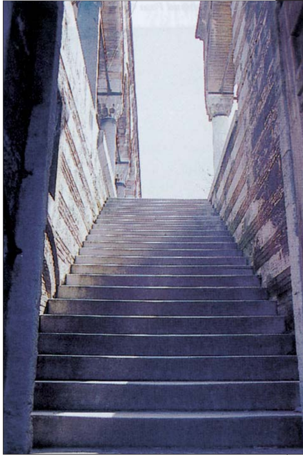
12. Zal Mahmud Paşa Külliyesi'nde Terasları Birleştiren Merdiven
