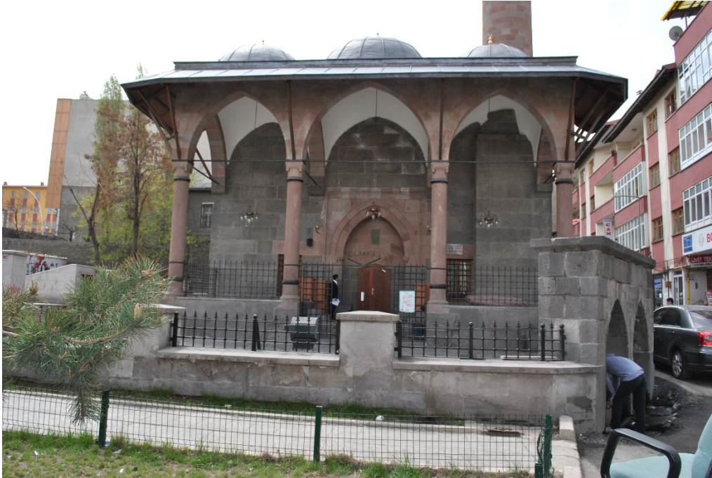
Resim 1: Bakırcı Camii kuzey cephe (Atak, 2012)
