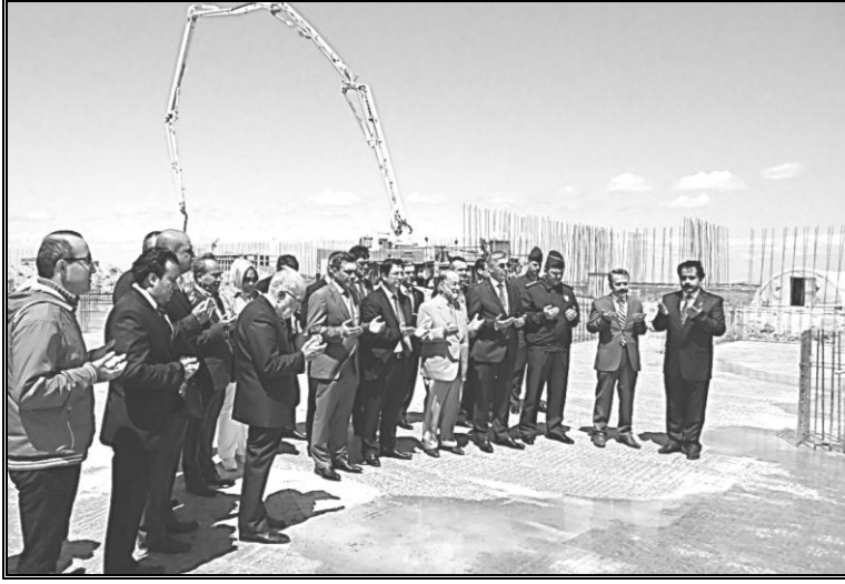
Fakülte inşaatı temel atma töreni.
