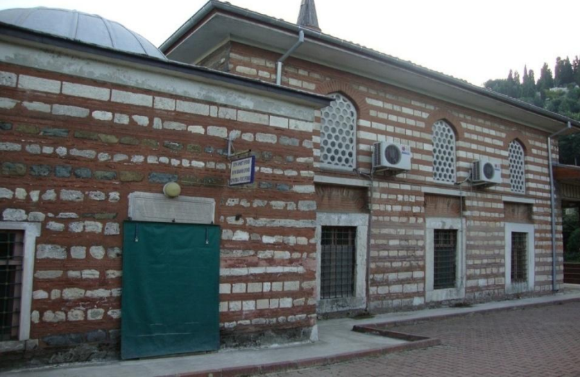
F.10-Şâh Sultân Tekkesi'ne âid türbenin dıştan görünüşü onarımdan önceki hâli (2012) Nuran Çetin Arşivi.
