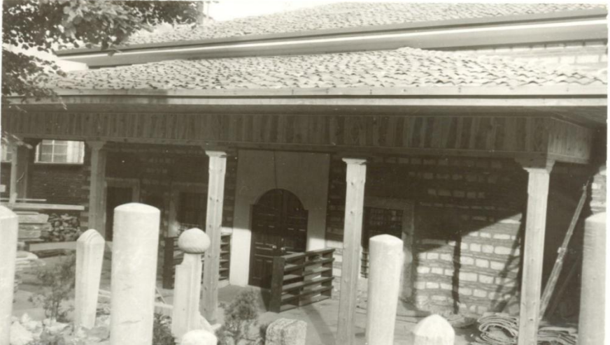
F.1- Şâh Sultân Tekkesi Mescid-Tevhidhânesi'nin dıştan görünüşü (1971) İstanbul Vakıflar Bölge Müdürlüğü Arşivi.
