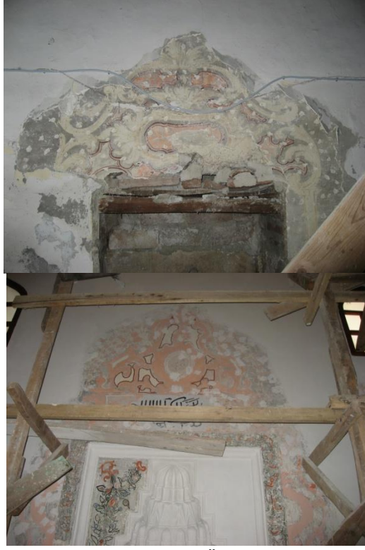
Fotođraf 9. 2008 Restorasyonu Öncesi Kalemiřlerinin Durumu. 46
