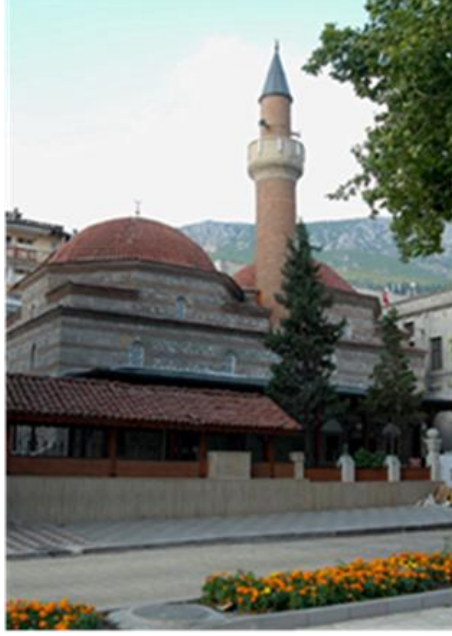
Fotoğraf 10. Saraçhane Camii Kuzey Cepheden Genel Görünüş.
