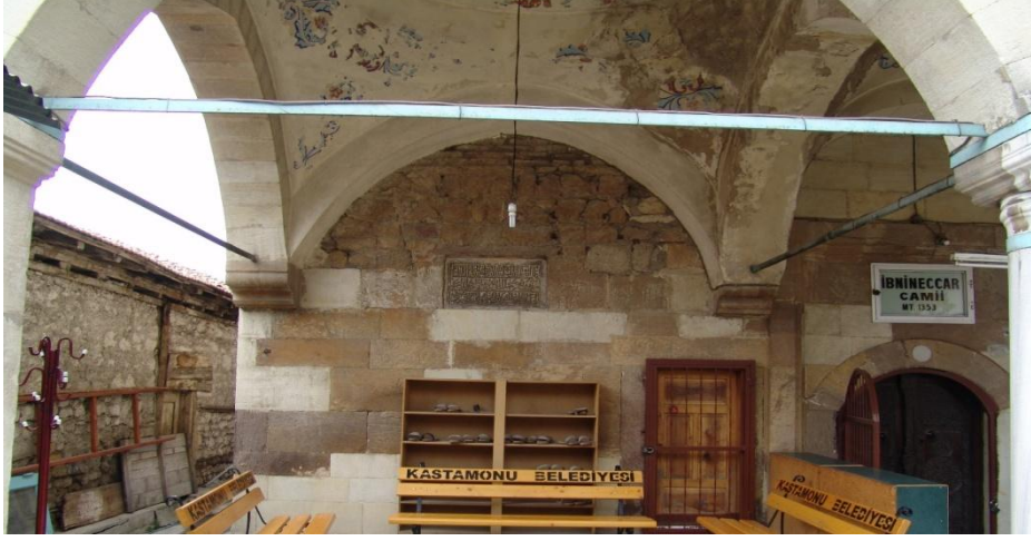
Resim 3: Kitabenin Cami Giriş Yönüne Göre Kapının Sol Tarafındaki Cephe Duvarı Ortasında Görünümü
