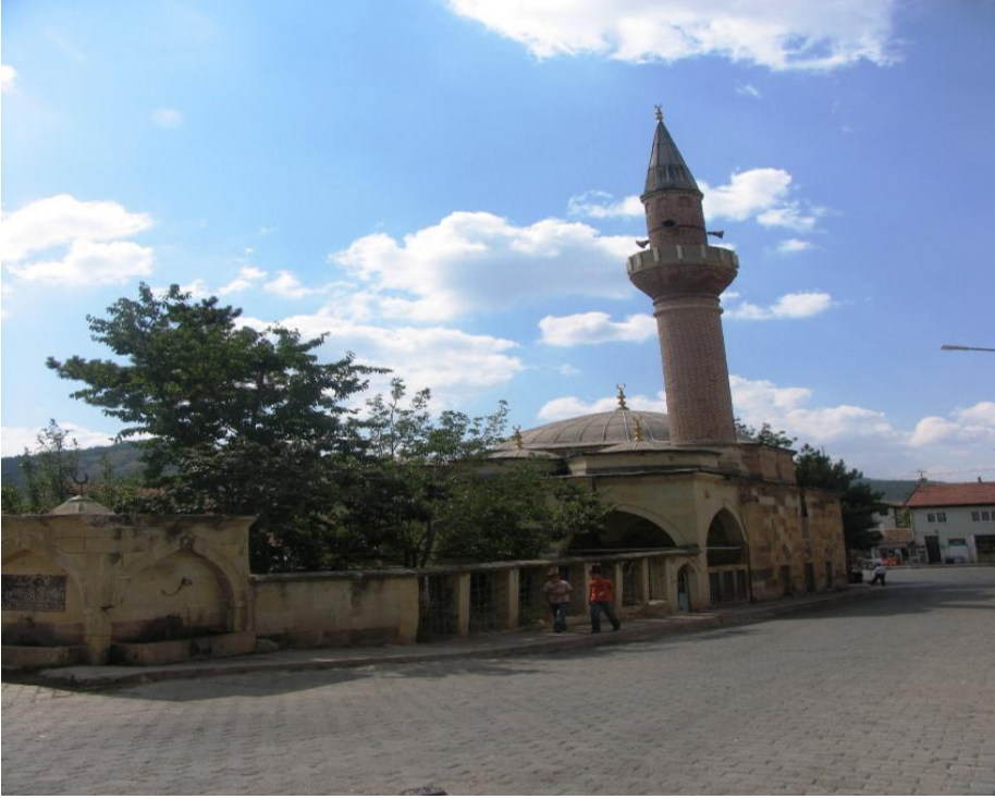
Resim 1: Caminin Kuzey Batı Köşesinden Görünümü
