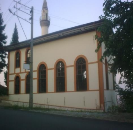
Fotoğraf 3, batı cephe(2012)
