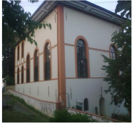
Fotoğraf 12, batı cephe(2012)
