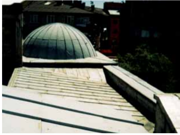
Şekil 16. Buruciye Medresesi'nin 1960'lardaki onarımı sonrası taş kaplamalı üst örtüsü ve ilerleyen yıllarda üzerinin metal malzemeyle kaplandığı görünümü (VGM Arşivi).
