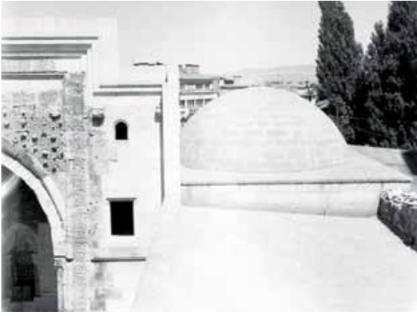
Şekil 16. Buruciye Medresesi'nin 1960'lardaki onarımı sonrası taş kaplamalı üst örtüsü ve ilerleyen yıllarda üzerinin metal malzemeyle kaplandığı görünümü (VGM Arşivi).
