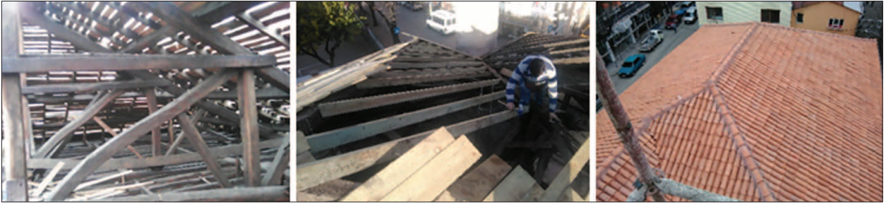
Fotoğraf 29. Çınarlar Camisi çatı onarımı fotoğrafları.
