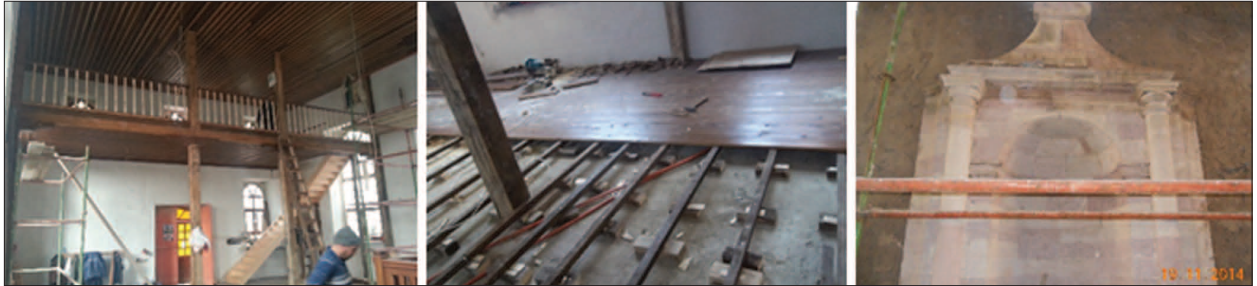
Fotoğraf 18. Şeyh Keramet'in Camisi onarım işleri fotoğrafları.
