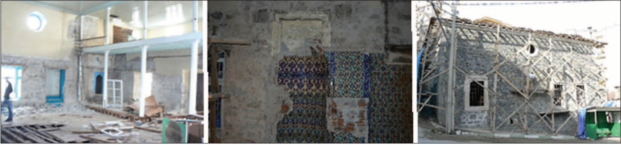
Fotoğraf 3. İç ve dış sıva söküm işlemleri.
