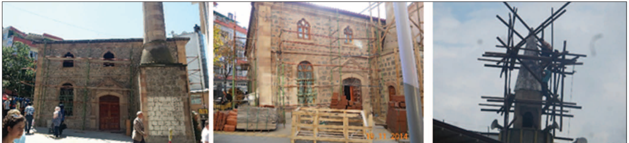
Fotoğraf 19. Şeyh Keramet'in Camisi cephe ve minare işleri fotoğrafları.
