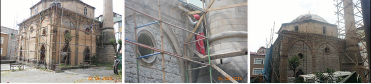
Fotoğraf 24. Kapu Camisi cephe ve yüzey temizliği fotoğrafları.
