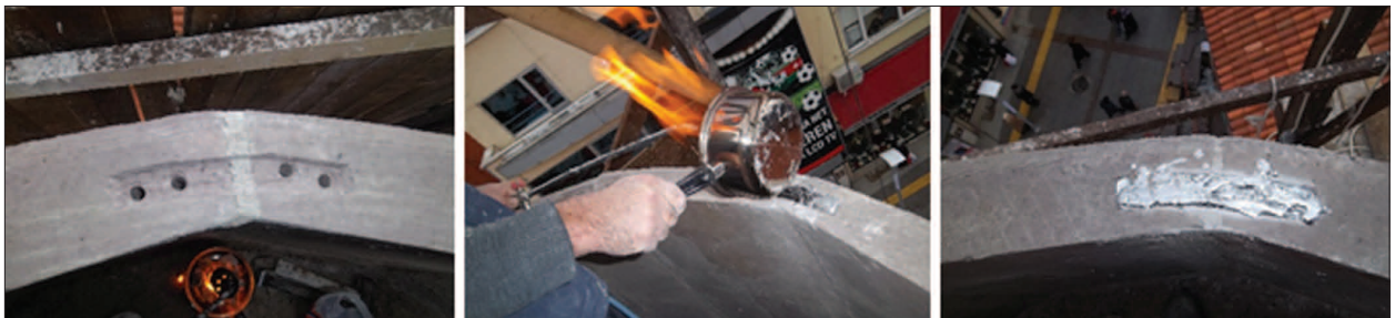
Fotoğraf 20. Kurşun kenet yapılması fotoğrafları.
