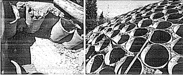
Fotoğraf 13.(a)Tuğladan örülmüş kubbenin yüzeyi. (b) Künkleri tutan düzensiz yerleştirilmiş demirler.
