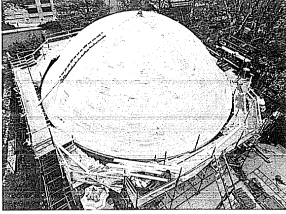
Fotoğraf 20. Ahşap kaplamanın tamamlanmış hali.
