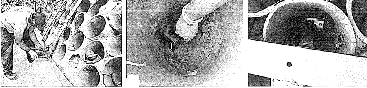
Fotoğraf 15.(a) Düşey plakaları etekdeki plakaya montajı, (b,c) künklerin içinden kubbe yüzeyine 316 paslanmaz çelik malzemeden ayak montajı.
