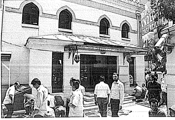
Fotoğraf 8. Kuzey cephesi.
