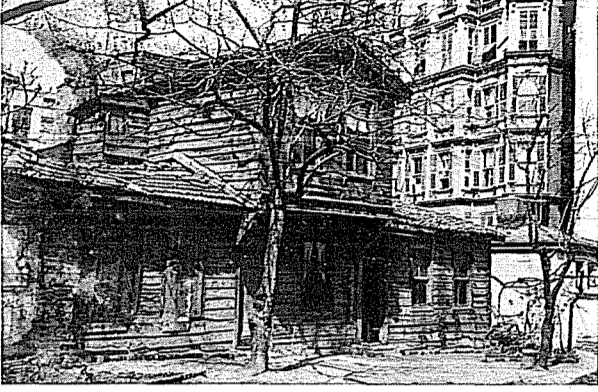
Fotoğraf/Belge 11. Avlu içindeki kuzey bahçe duvarına yaslanan ahşap müstemilat yapısı (Encümen Arşivlerinden Alınmıştır, tarih bilinmemektedir).
