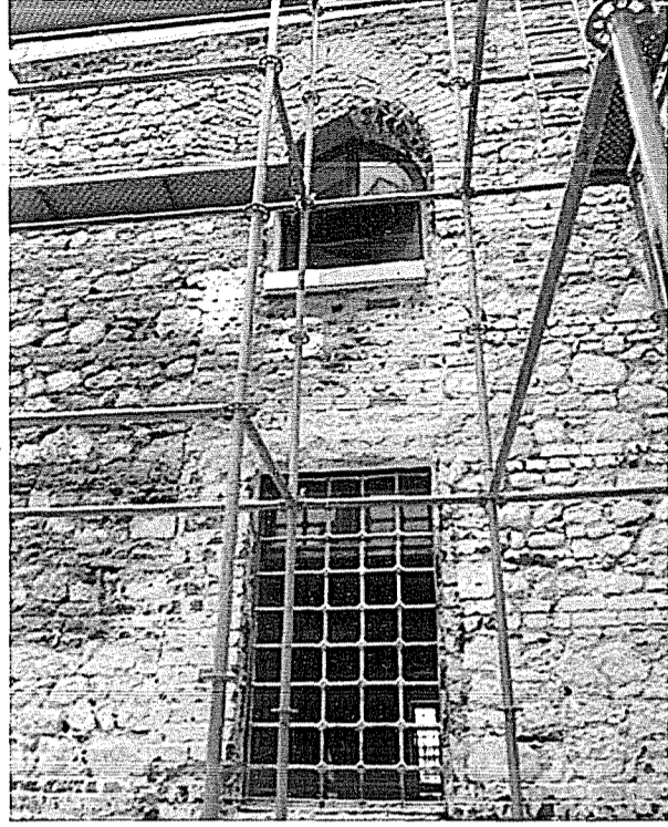
Fotoğraf 22b. Uygulamada yapılan çimento harçlı siva raspaı Sonucunda, son cemaat yerinin özgün pencere ebatlarının 1938 yılındaki onarım ile değiştirildiği tespit edilmiştir.
