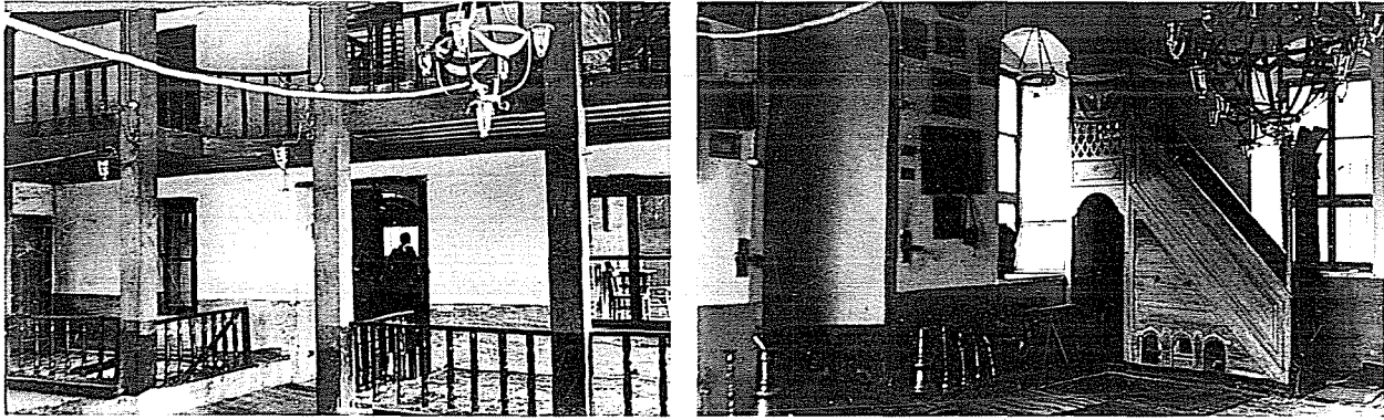
Fotoğraf 12-13. Caminin içinden, solda güneybatı, sağ ahşap mahfil ve giriş kapısı (Encümen Arşivi).
