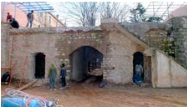
Fotoğraf 27. Tabhane (F Blok) kaldırılmış betonarme ek
