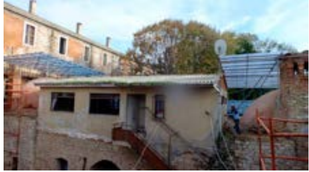
Fotoğraf 18. Tabhane (F Blok) betonarme ek
