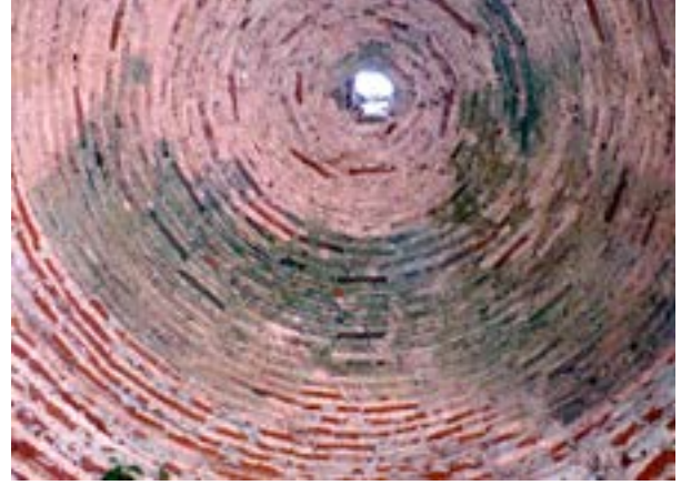
Fotoğraf 22. Dar'ül Hadis (E Blok) kubbede yosunlanma ve rutubet
