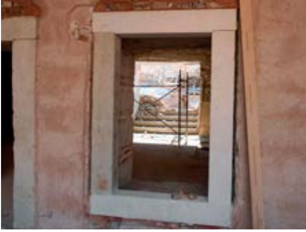
Fotoğraf 38. İmarethane (D Blok) söve tamir ve yenilemesi
