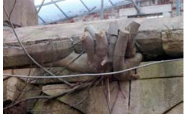
Fotoğraf 20. (Tabhane) F Blok silmeden çıkan bitki kökleri
