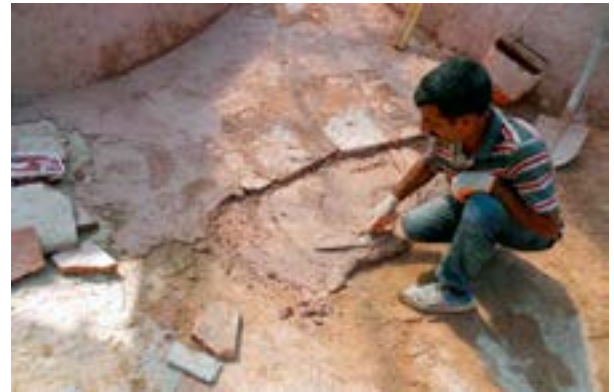
Fotoğraf 29. İmarethane (D Blok) çatıda kurşun altı tesviyesinin yapılması
