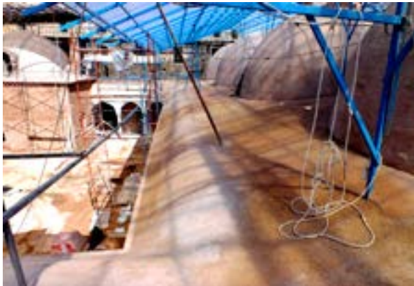
Fotoğraf 30. İmarethane (D Blok) kurşun altı çamur siva uygulaması
