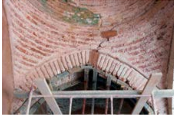
Fotoğraf 32. Da'ül Hadis (E Blok) kubbe ve kemerde tuğla tamirleri
