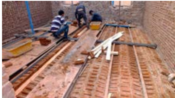
Fotoğraf 36. Kervansaray (A Blok) volta döşeme tamirleri
