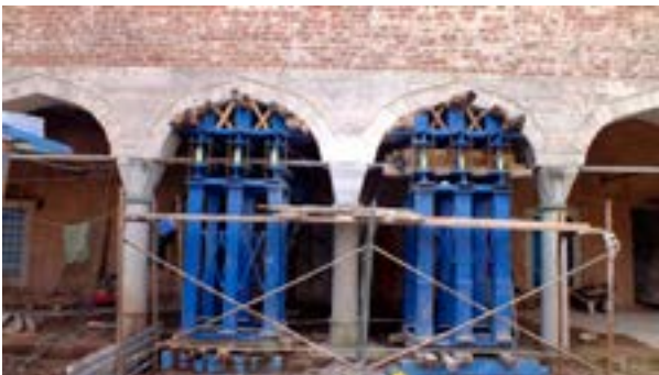
Fotoğraf 37. Darüşşifa (G Blok) -sütun başlıkları için hazırlanan çelik askı iskeleleri
