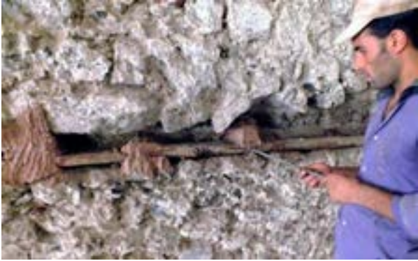
Fotoğraf 33. Ahşap hatıl uygulaması
