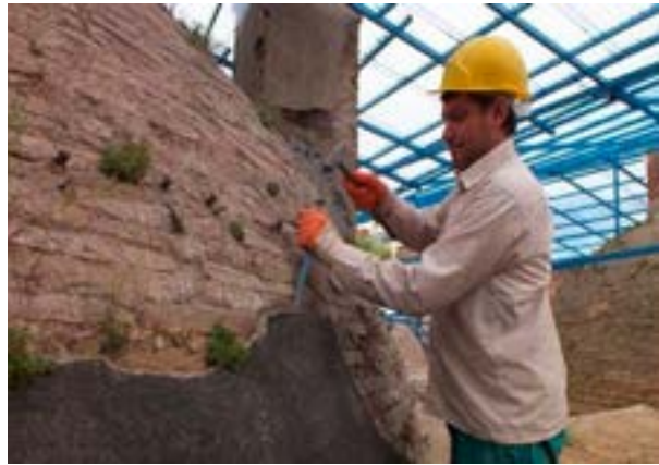
Fotoğraf 26. İmarethane (D Blok) kubbelerde sıva raspalarının yapılması
