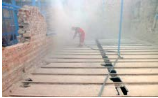
Fotoğraf 34. Kervansaray (A Blok) volta döşemelerde kumlama uygulaması
