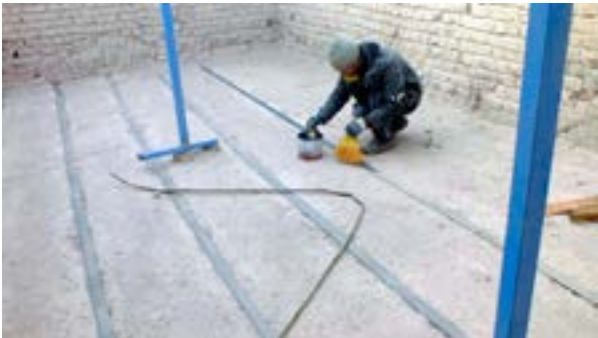
Fotoğraf 35. Darüşşifa (G Blok) kumlama sonrası galvanik koruyucu uygulaması
