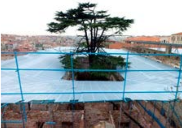
Fotoğraf 25. Kervansaray (A Blok) koruyucu çatı uygulaması
