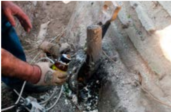
Fotoğraf 28. Çatılardaki bitkilerin kimyasal ilaçlama ile kurutulması
