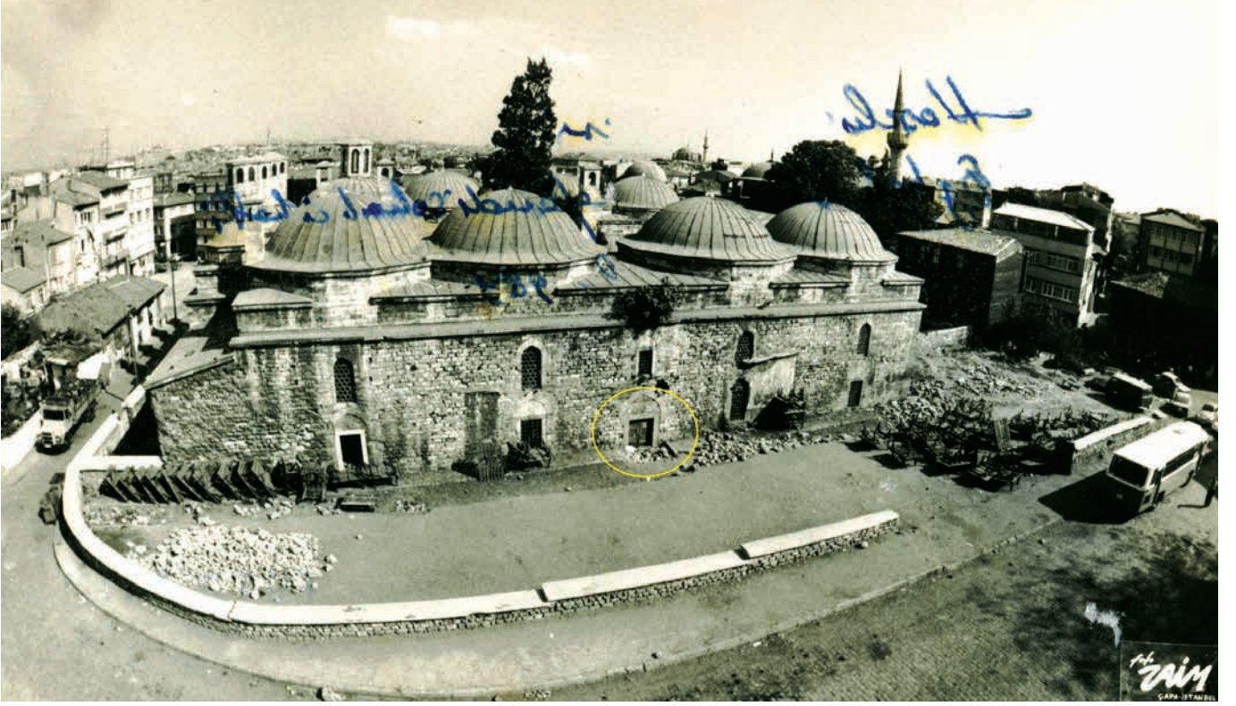
Fotoğraf 23. Haseki İmaret, 1984 restorasyonu öncesi (Vakıflar Arşivi)
