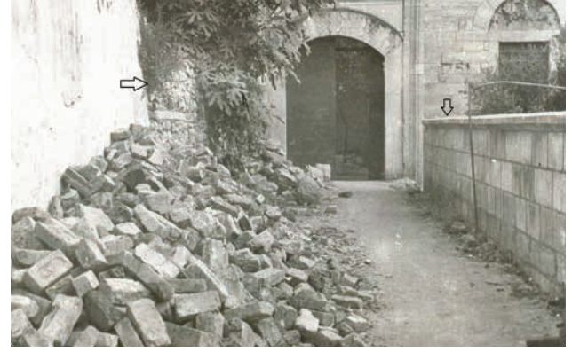
Fotoğraf 16. İmaret aralığı (Vakıflar Arşivi, 1968 onarım dosyası)
