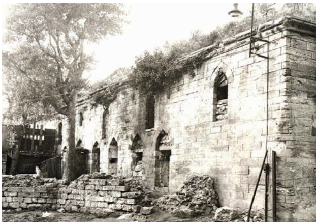
Fotoğraf 10. Medresesinin Sami Paşa Sokağı cephesi, restorasyon öncesi (Vakıflar Arşivi, 1960 onarım dosyası)
