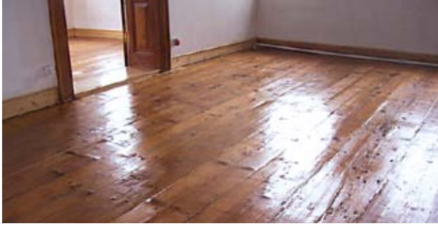
Resim, 72- Cila sonrası zemin döşemesi
