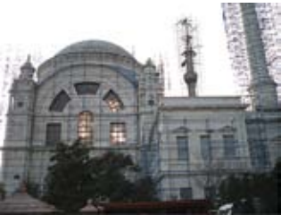
Resim, 40- Batı cephesi temizlik öncesi
