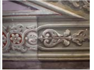
Resim, 53 ve 54- Non-iyonik deterjanla kalemişi yüzeylerde temizlik yapılması
