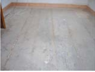
Resim 70- sistire öncesi zemin döşemesi
