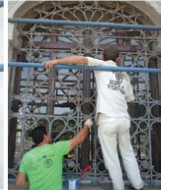
Resim, 46- Demir korkuluklara yeniden boya yapılması
