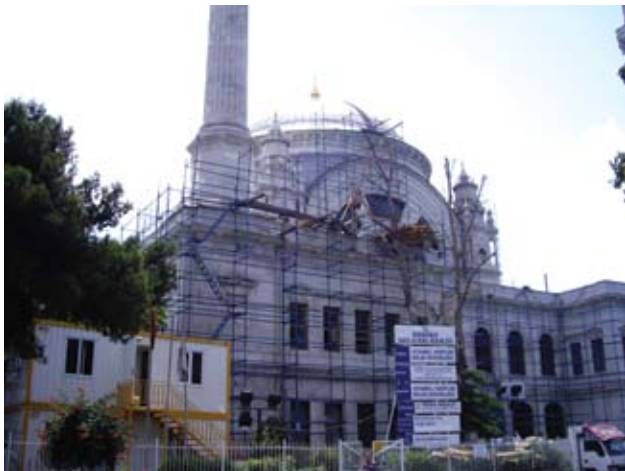
Resim, 15- Şantiye binası, cami kuzey cephesi
