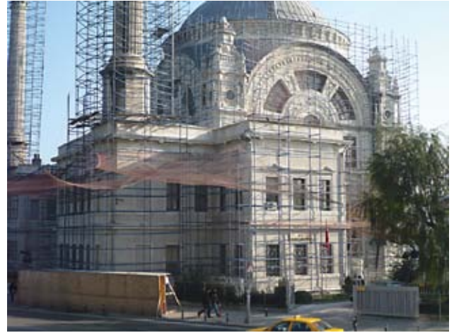
Resim 16- İskele ve yayalar için yapılmış güvenlik tüneli
