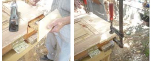
Resim, 65 ve 66- Yeni kapı parçalarının yerlerine alıştırılması ve işkencede bekletilmesi
