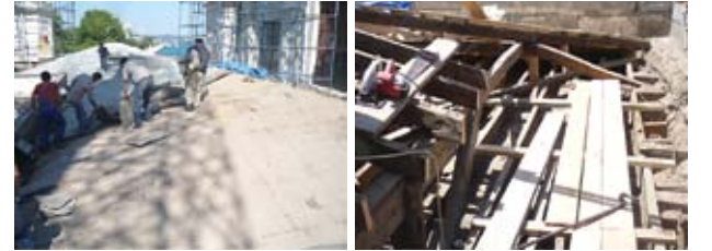
Resim, 34 ve 35- Hünkar Mahfili eski çatısı ve kurşun sökümü
