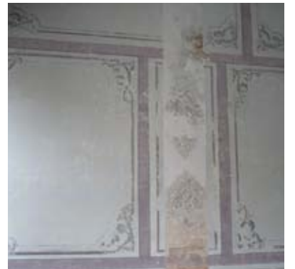
Resim,56- Kireç esaslı ince harç enjeksiyonu müdahalesi sonrası
