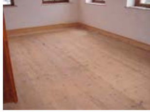
Resim 71- sistire sonrası zemin döşemesi
