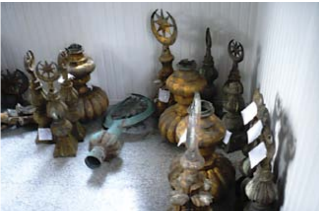
Resim, 20-Tamir maksadı ile sökülmiş alemler
