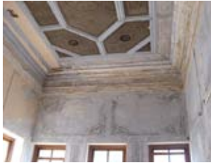
Resim, 59- Boya altında bulunan kalem işlerini açığa çıkaran raspa sonrası
