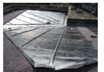
Resim, 38- Hünkar Mahfili çatısı; keçe üzerine yeni kurşunların döşenmesi
