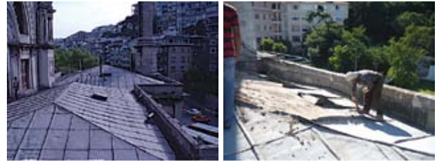
Resim, 32 ve 33- Hünkar Mahfili eski çatısı ve kurşun sökümü
